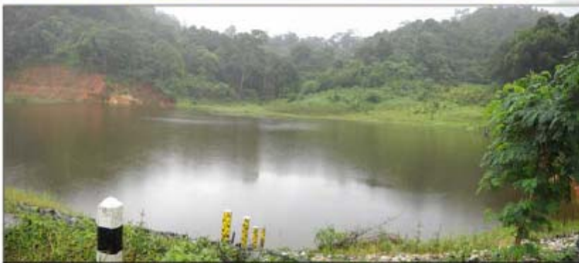
8.อ่างเก็บน้ำ
